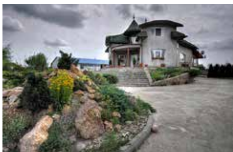
Villa Palics, Tera Term hőszivattyúval
