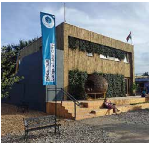
A déli homlokzat és a keleti oldal a gépészeti térrel
