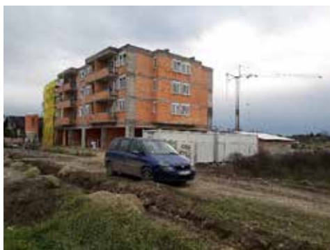
Épülszerkezet, betonváz blokkokkal
