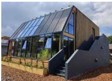
Az északi homlokzat, a gépészeti térrel
