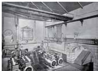
Kaposztásmegyeri gépház gőzgép hajtotta dugattyús szivattyúkkal 1910
