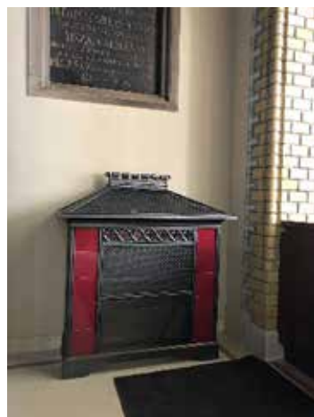
Felújított gázkandalló új feladattal ellátva a főbejárat mellett
