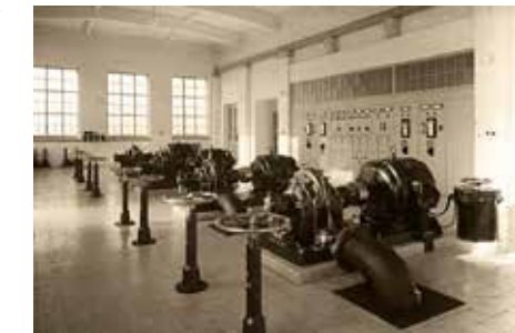
A Békásmegyeri gépház villanymotorok-kal hajtott centrifugál szivattyúk a 30-as évek végén
