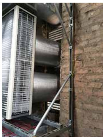
A kültérik a toronyban nyomóoldalon légszűrővel
