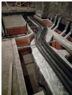
Gépészeti vezetékek/ légcsatornák vezetése a pincei padlócsatornában
