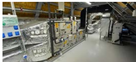
Légkezelők elhelyezése a padlástérben
