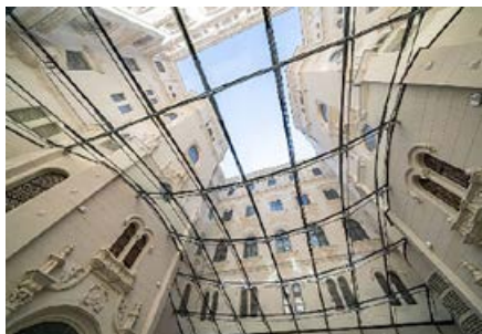
Újja épített kémény, hő és füstelszívás funkcióval
